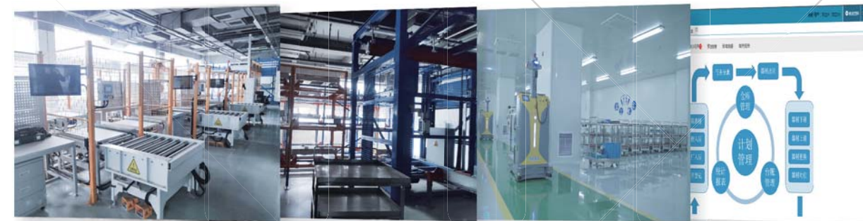
自动化平台检修 立体库 AGV 器材全生命周期管理系统截图
